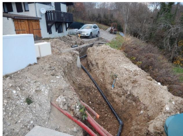
Poste de relevage de Combe Louvière dont la canalisation de refoulement a dû être remplacée car l'entreprise Gauthey avait posé un tuyau sous dimensionné par rapport aux prescriptions du marché de travaux.
