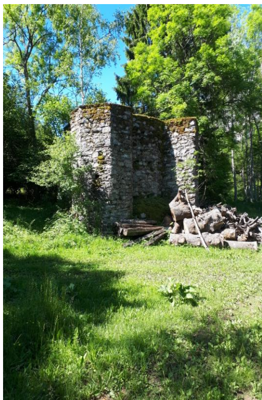
VESTIGES DES AMENAGEMENTS PRES DE BELLECHAMBRE
