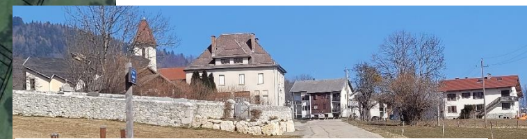
Entrée des Prés avant démolition de l'ancienne mairie
