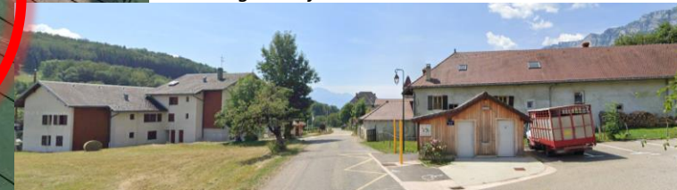
Une urbanisation plus dense en entrée de villages par de l'habitat diversifié, des équipements, et la présence de vieux corps de ferme aux volumes imposants : le cœur de village d'aujourd'hui
